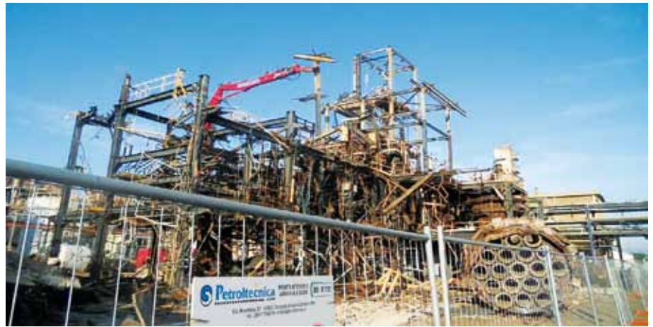
Demolizione zone reazione area TRI/Per
