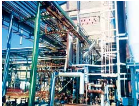
Demolizione edificio lato rack in esercizio concentrazione soda
