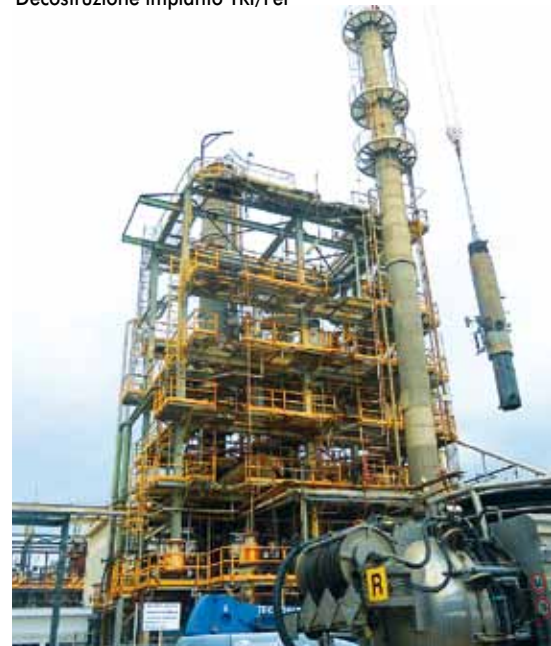
Decostruzione impianto TRI/Per
